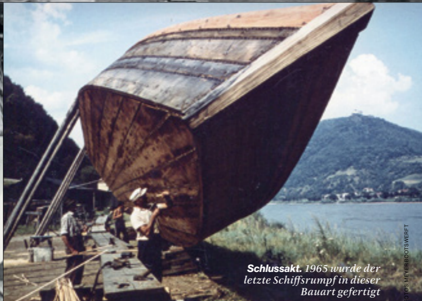
Handarbeit. Die Fugen zwischen den Planken wurden mit saug- und quellfähigem Moos verstopft und mit Holzleisten abgedichtet – Schoppen nennt sich das
